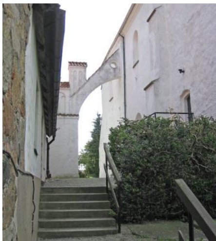
Dalby kirke er forsynet med en stræbepiller, der holder muren på plads. Som det ses, svajer den ud ad. Det samme ses på Østerlars kirke
